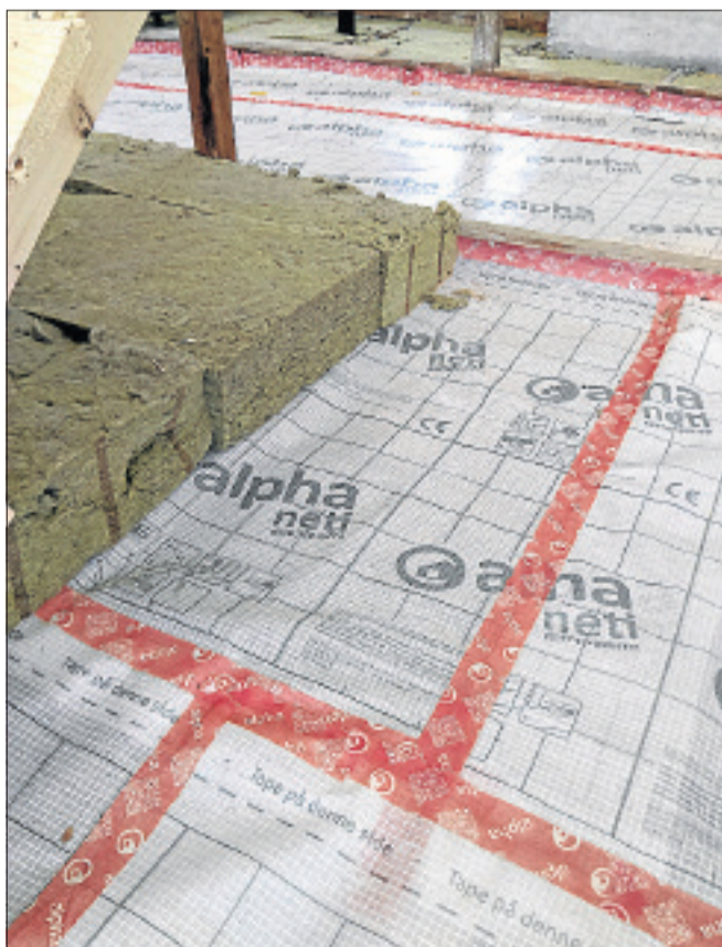
En armeret dampspærre er dobbelt så stærk som en plastdampspærre – det giver større sikkerhed for robuste og tætte samlinger. (Foto: Johnny Lundgreen)
