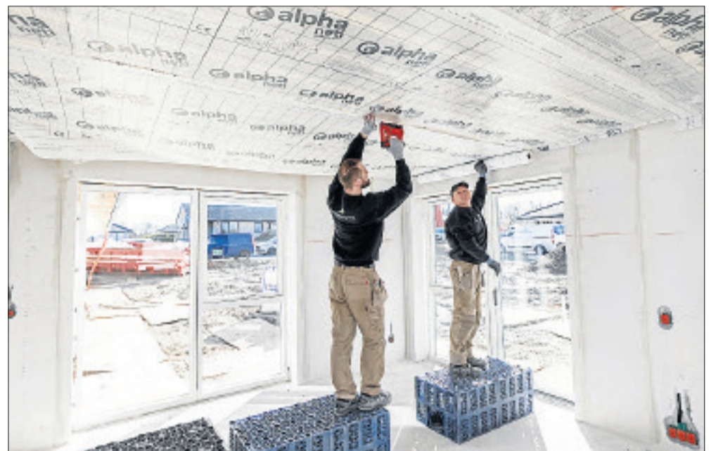
Med en armeret dampspærre er det ikke nødvendigt med fast underlag ved samlinger, der tapes. (Foto: John Ehbrecht)
